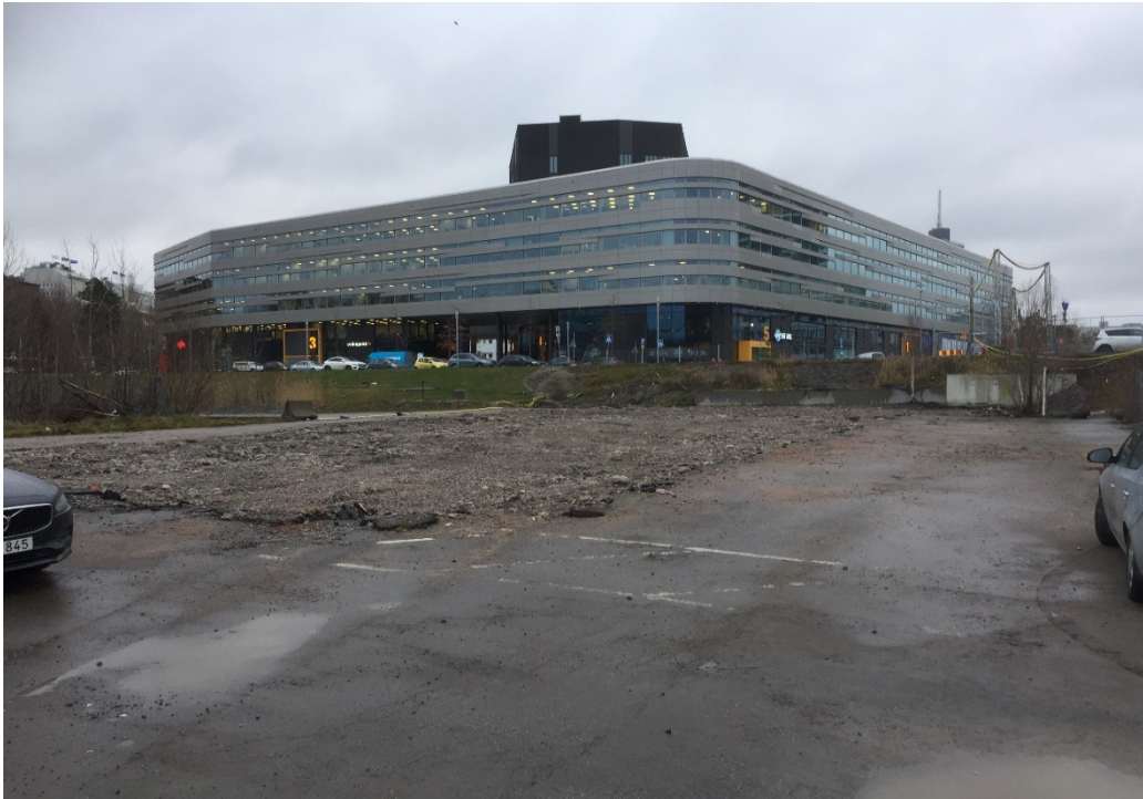
Figur 3. Yta efter borttagen byggnad
