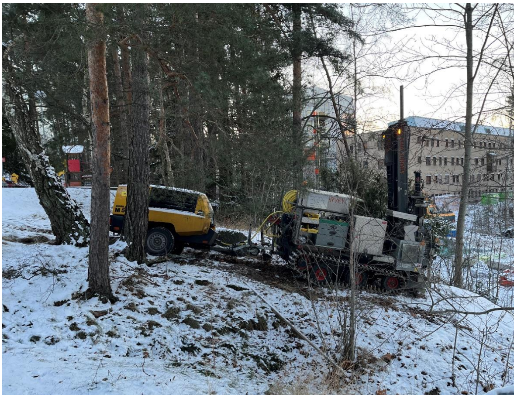
Bild 1. Skruvborrsprovtagning av berg vid provpunkt 21SE_01.
